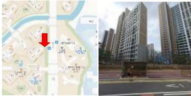
2. 탕정 호반아파트 호반3차 앞 버스정류장
